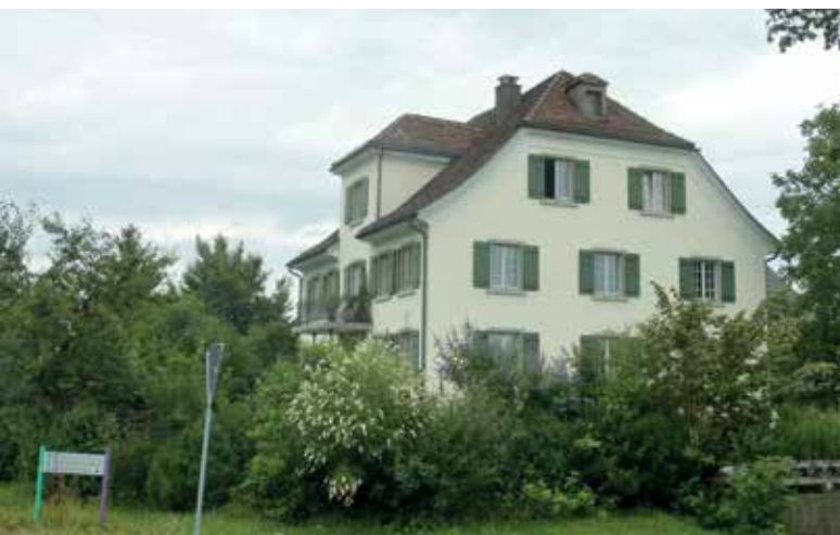
Bollier-Haus beim Diakonenhaus Greifensee
